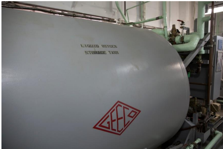
↑ 液体酸素・窒素生成装置及びタンク ↓
